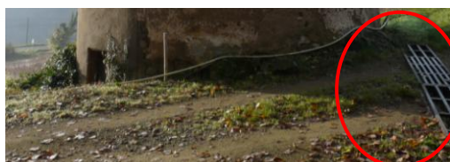
Document 21 : Détail de la grill (Vue Nord)
