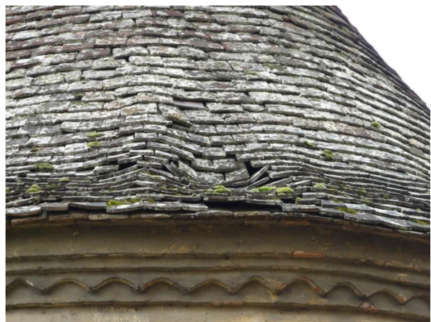
Document 17 : Détail du toit du colombier de Varenne (Vue Est)
