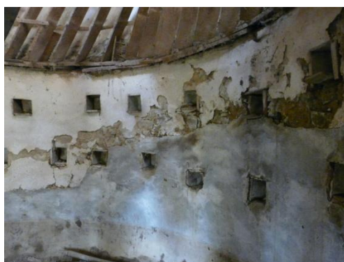
Document 23 : Détail mur colombier de Varenne
