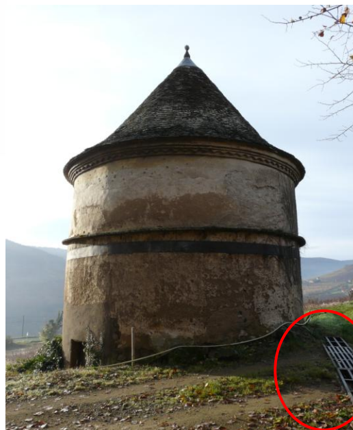
Document 18 : Façade Nord Est du colombier de Varenne
