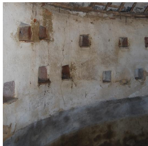
Document 9 : Détail trous de boulins du colombier de Varenne
