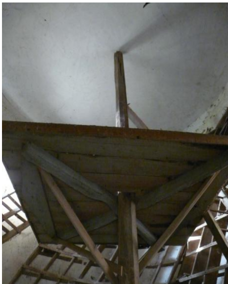
Document 8 : Détail du plafond et du plateau du colombier de Varenne
